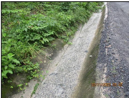
ภาพที่ 2.13 สภาพถนนและร่องระบายน้ำบริเวณถนนขึ้นเหมือง
